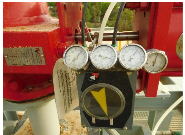
Sistema de ajuste neumático del hidroclasificador TAK.
